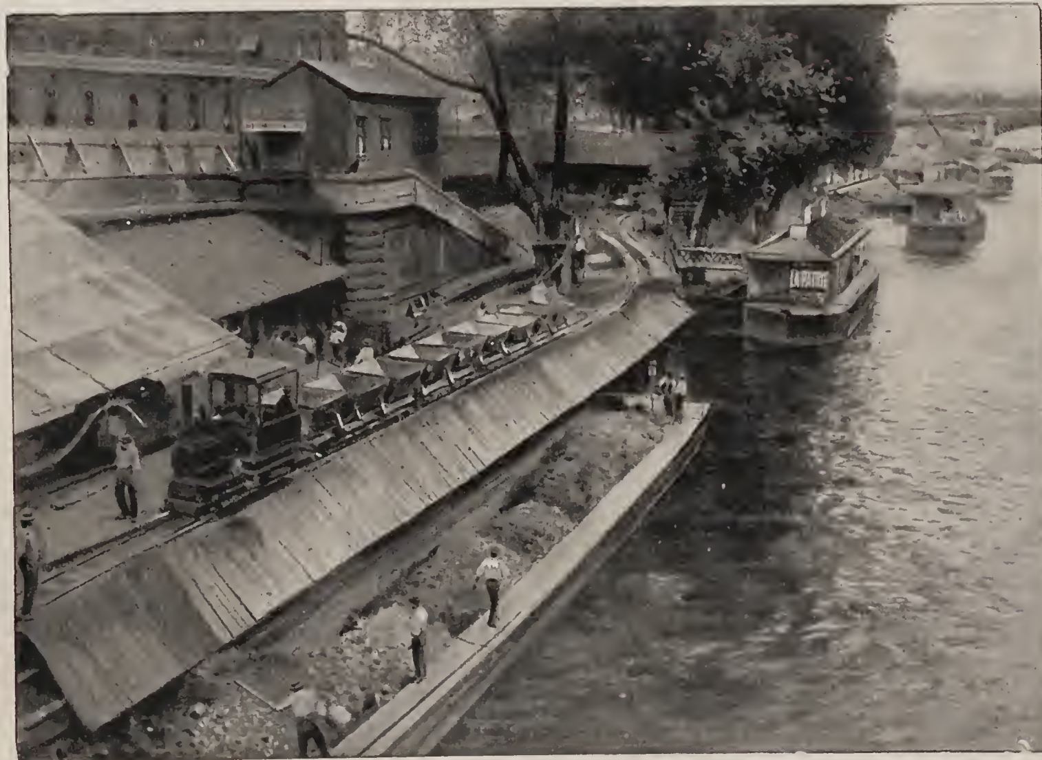
LE PROLONGEMENT DES LIGNES DE LA C te D'ORLÉANS. — Évacuation des déblais par bateaux clapets. (Quai d'Orsay.)
